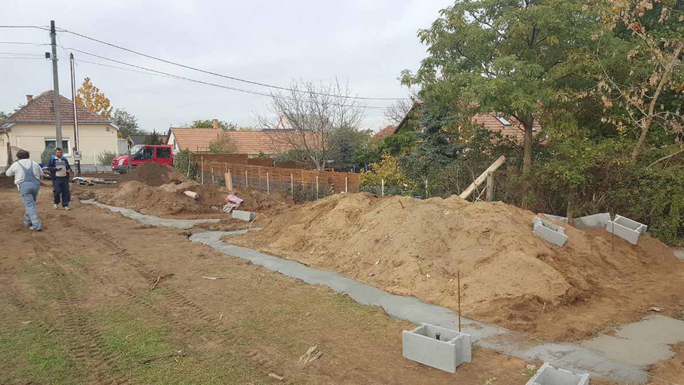
Alap betonozás
